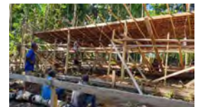
Pig house under construction (Komuniboli)
