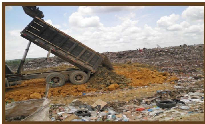
Foto 4-7. Vaciado del material de cobertura
