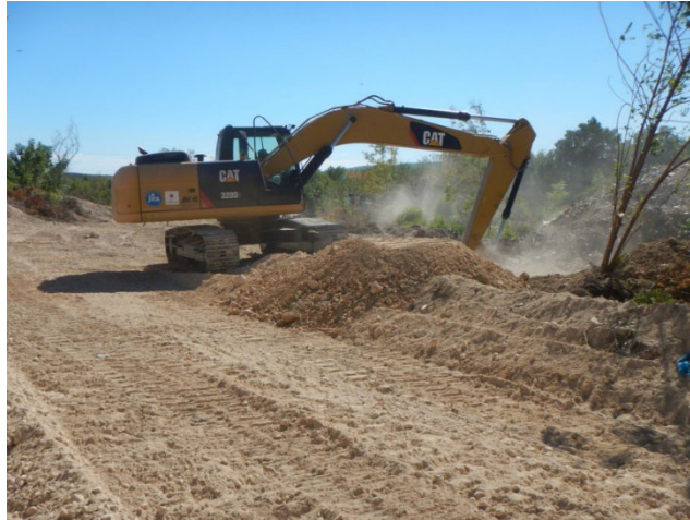
Foto 3-4. Excavación de material de cobertura en el SDF de Azua
