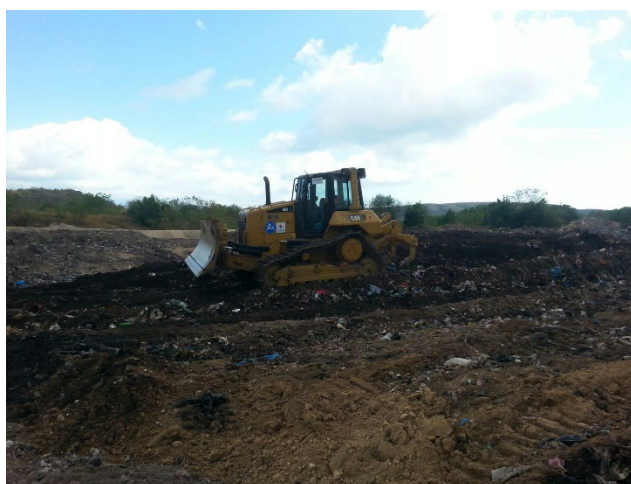
Foto 3-2. Buldócer esparciendo residuos en la rehabilitación del SDF de Azua
