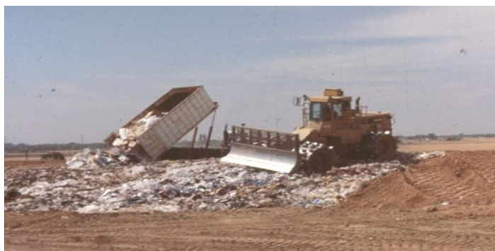
Foto 1 Esparcimiento, compactación y cobertura en un vertedero
