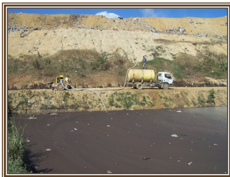
Foto 5-4. Recirculación de lixiviados en la masa de residuos
