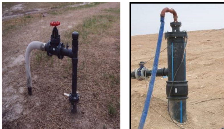
Foto 5-1. Pozos verticales de extracción
