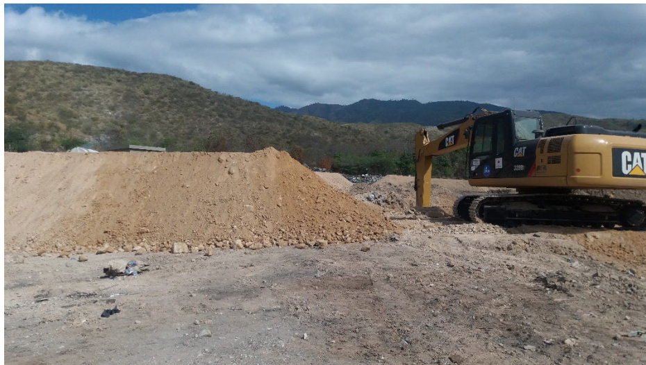
Foto 3-4. Excavación de material de cobertura en el SDF de Azua
