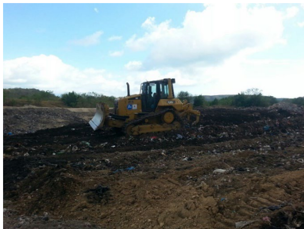
Foto 4-4. Esparcimiento y compactación de residuos con excavadoras en el SDF de Azua
