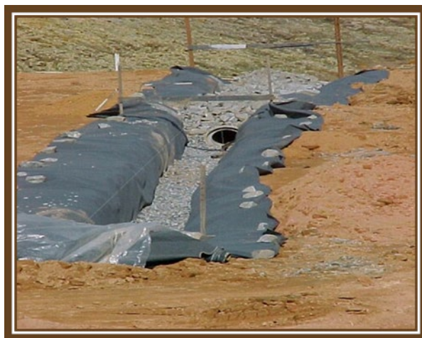
Foto 4 Construcción de drenajes para la recolección de lixiviados
