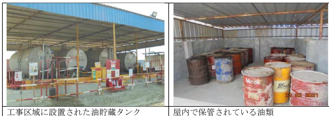
図 13.4-5 事業計画地内での油類や化学物質の保管例（1/2 号機事業）
