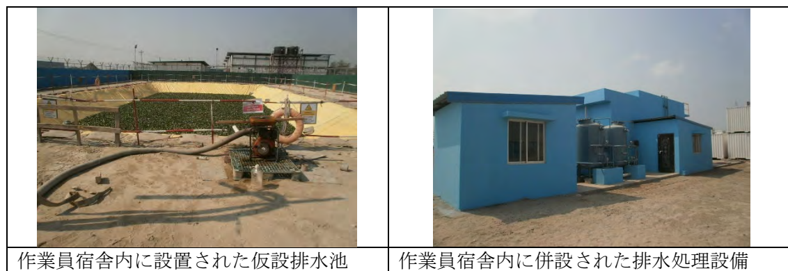
図 13.4-4 事業計画地内での工事中の排水対策例（1/2号機事業）
