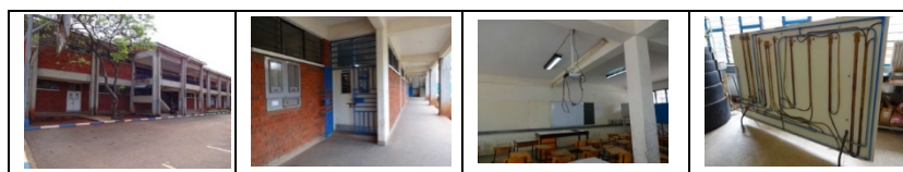
写真 3-2 漏水探知関連施設
