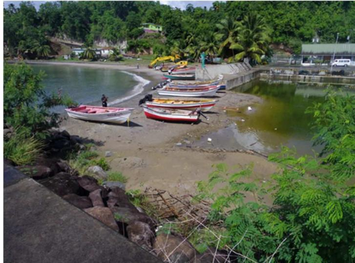
写真 4-2-1-1(1) 港口部の完全閉塞(2015年11月4日、報告書2):写真 6-52 の引用)
