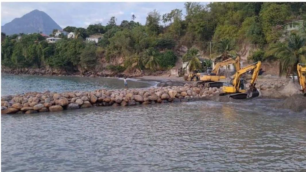
写真 2-1-3(1) 地元建設会社によるアクセス道路(第2防砂突堤の基礎)及び浚渫工事状況
