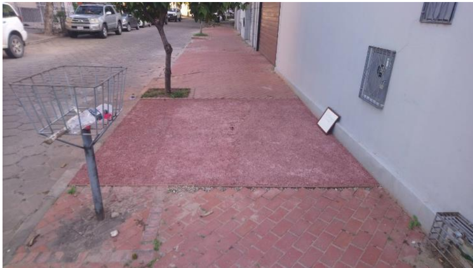
図 12 試験施工完了後 1 週間後、その 2
