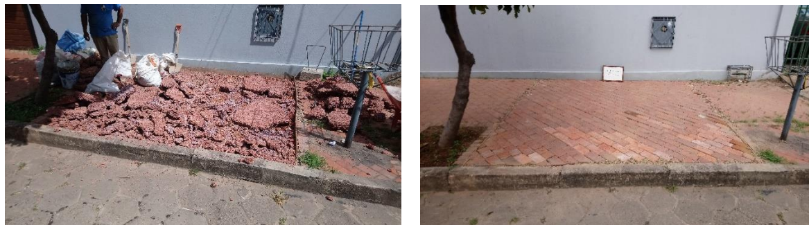
図 14 撤去工事・回復工事後
