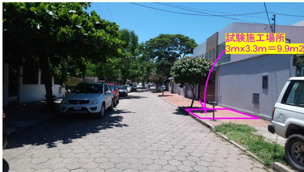
図6 施工箇所(第1環状方向)
