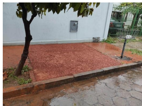
試作設置箇所 雨天の状況
