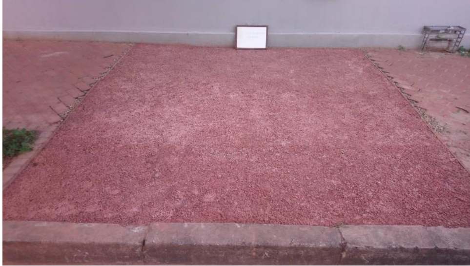
図 11 試験施工完了後 1 週間後、その 1
