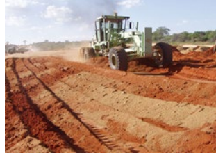
モーターグレーダ (攪拌・敷均し)
