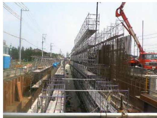
ポンプ車によるコンクリート打ち込み
