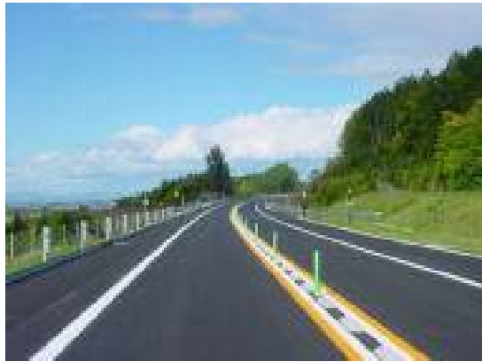
写真 2.4 アスファルト舗装
