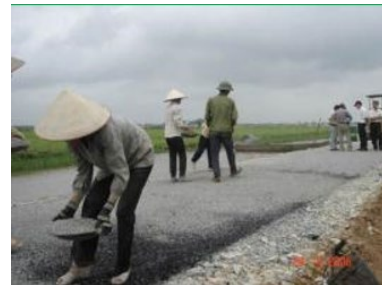
骨材散布 (人力施工)
