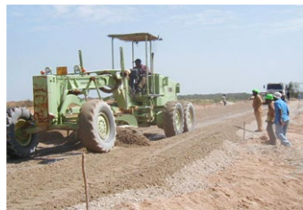
モーターグレーダ (攪拌・敷均し)
