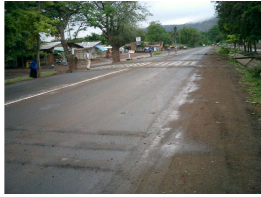
写真 2.28 予告ハンプの設置
