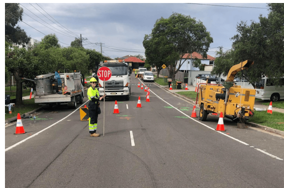
写真 3.21 交通誘導員の配置
