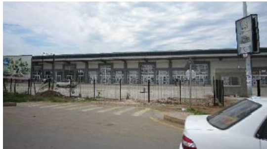
写真 2.19 ショッピングモールの建設
