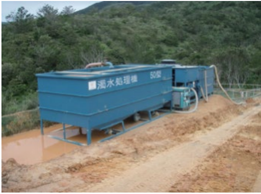
写真 3.22 濁水処理施設 (水質汚濁防止対策)
