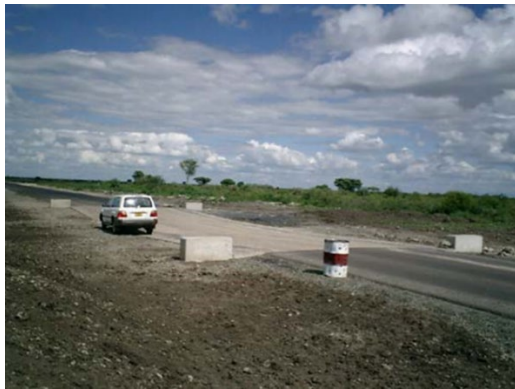
写真 2.25 速度抑制施設の機能を持つドリフト
