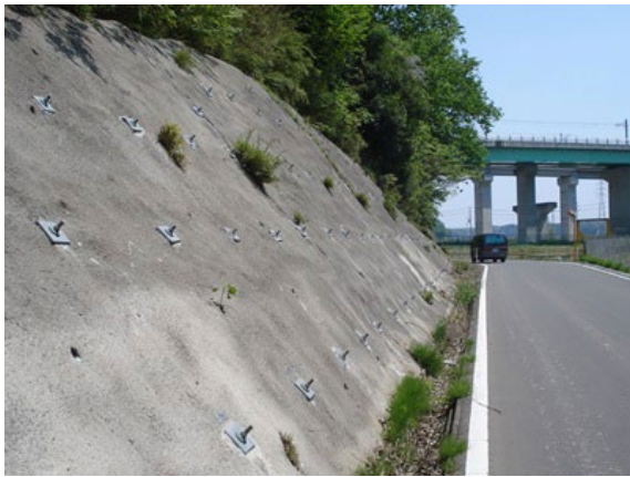
モルタル吹付工+ロックボルト工
