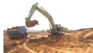
ダンプトラック積込み
