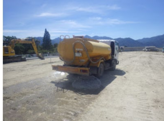
写真 3.23 散水車による散水 (粉じん対策)
