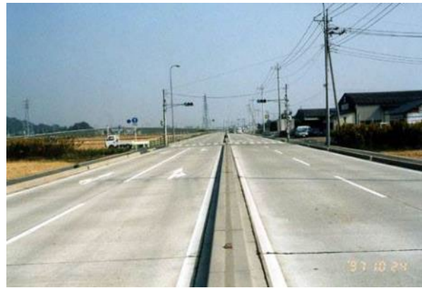
写真 2.5 コンクリート舗装
