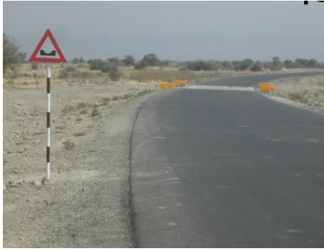
写真 2.23 緩勾配の低盛土
