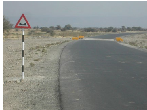
写真 2.26 ドリフト前の交通標識
