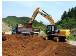
ダンプトラック積込み
