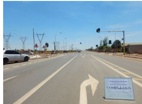
写真 2.18 整備後の道路
