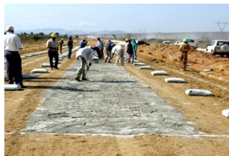
セメント散布(人力)
