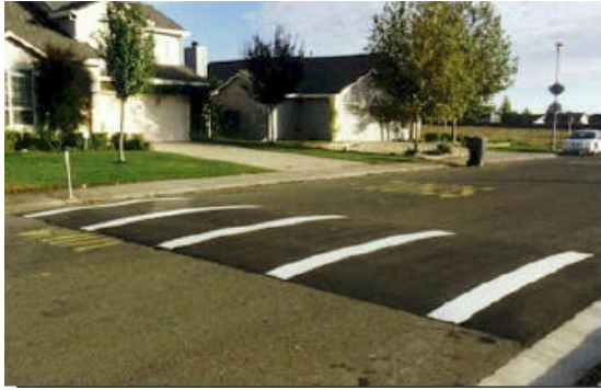
ハンプ設置事例
