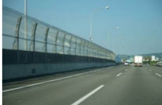
写真 2.13 遮音壁の設置
