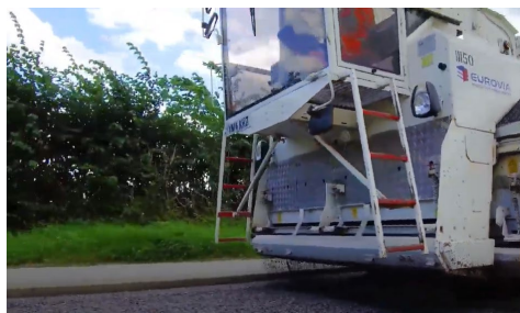
骨材散布 (機械施工)
