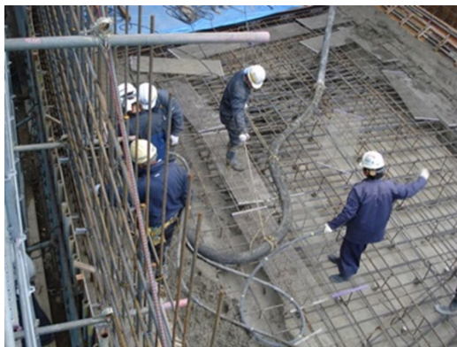
コンクリート打ち込みの様子
