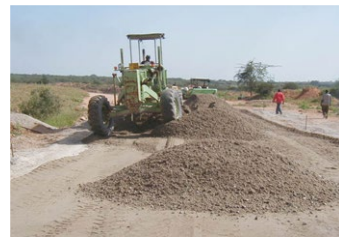
モーターグレーダ (仮敷き均し)
