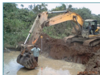
写真 2.2 施工時に発生した湧水
