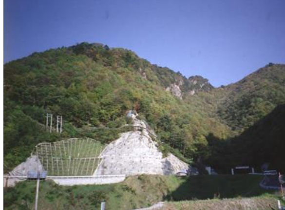
法枠工+モルタル吹付工
