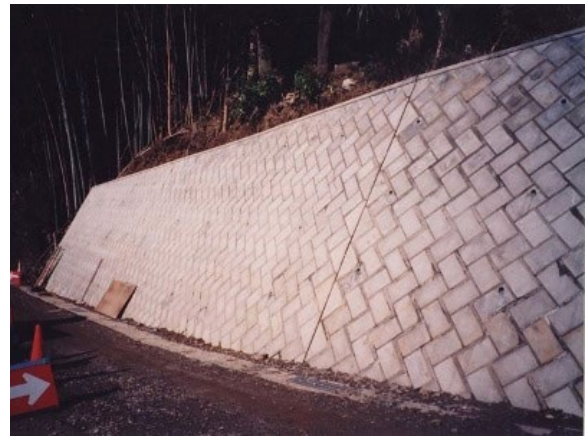
ブロック積み擁壁
