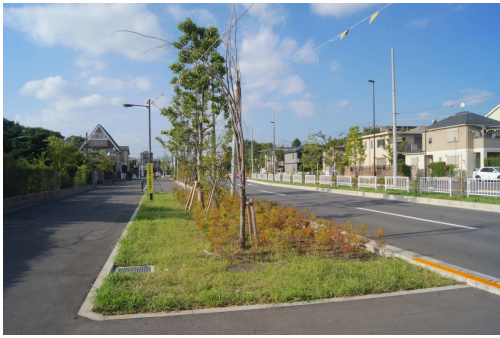
写真 2.14 環境施設帯の整備
