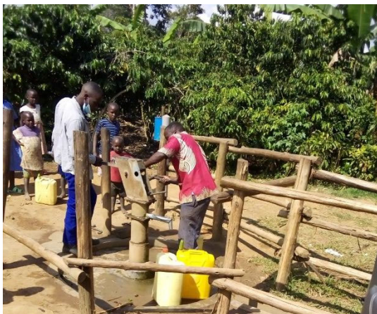
写真 17: サービスセンターによる井戸修理 (2018/11-2019/1)
