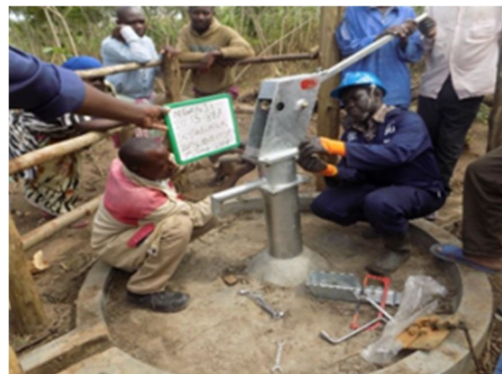
写真12：井戸改修に伴うハンドポンプ取換工事 (2018/4-2018/8, 2019/3-2019/6)
