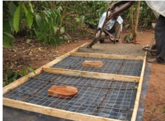
写真 26 : トイレのスラブ製作実演 (サニテーションマーケティング) (2018/8-2018/11)
