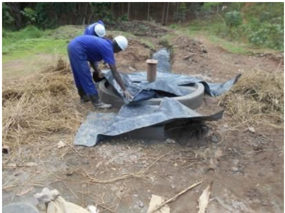
写真9：井戸の改修工事 (エプロン) (2018/4-2018/8, 2019/3-2019/6)
