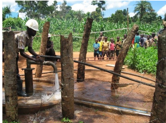
写真8：井戸の改修工事 (エアリフト) (2018/4-2018/8, 2019/3-2019/6)
