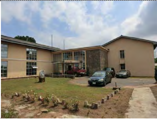
試験用検査機材の設置予定場所
