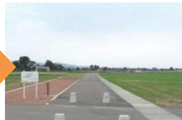
پس از احداث خط لوله
