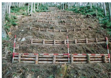
丸太を使った土壤保全対策
