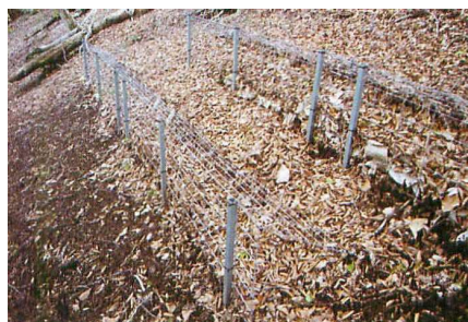
金網設置(金網工)による落葉の捕捉
