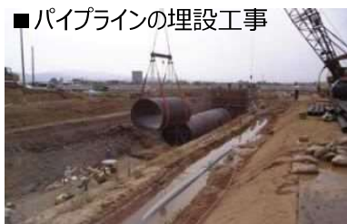
パイプラインの埋設 (鋼管: 口径3,500mm)
