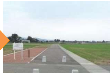
パイプライン埋設後
