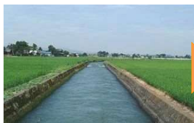
改修前の農業用水路
