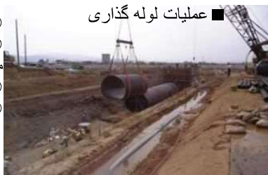
عملیات لوله گذاری لوله فولادی به قطر 3500 میلیمتر
