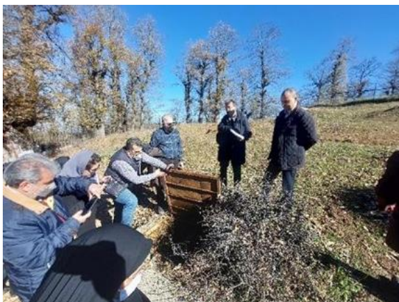
شیرفلکه تنظیم خروج آب از آب‌بندان (فاضل آباد)
