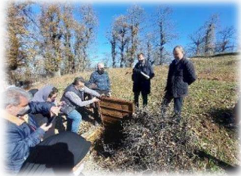
«منطقه ناهموار» محل شیر فلکه خط لوله متصل به آب بندان
