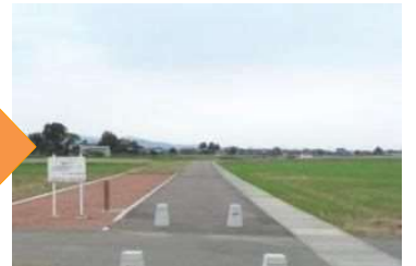
パイプライン埋設後
