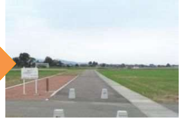
پس از احداث خط لوله
