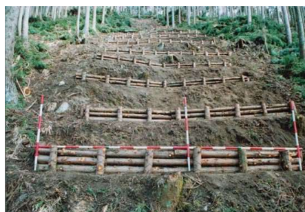
丸太を使った土壤保全対策
