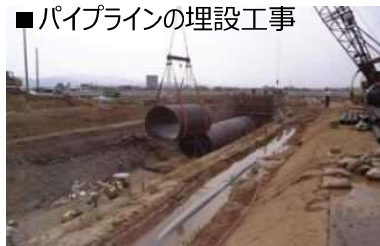
パイプラインの埋設工事 パイプラインの埋設 (鋼管：口径3,500mm)
