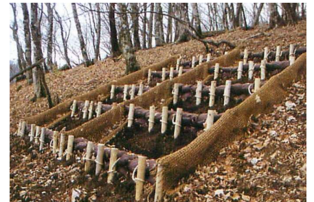
土のう工による落ち葉の捕捉
