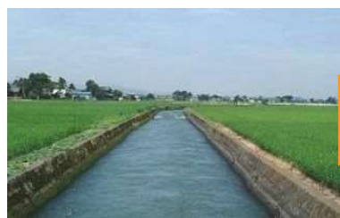
改修前の農業用水路
