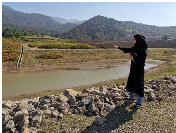
集水路と貯水池 (FazelAbad 地区)
