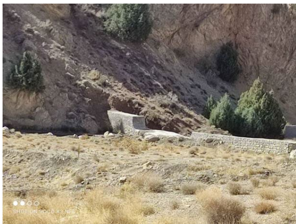
山間部の砂防堰堤 (Vala 地区)
