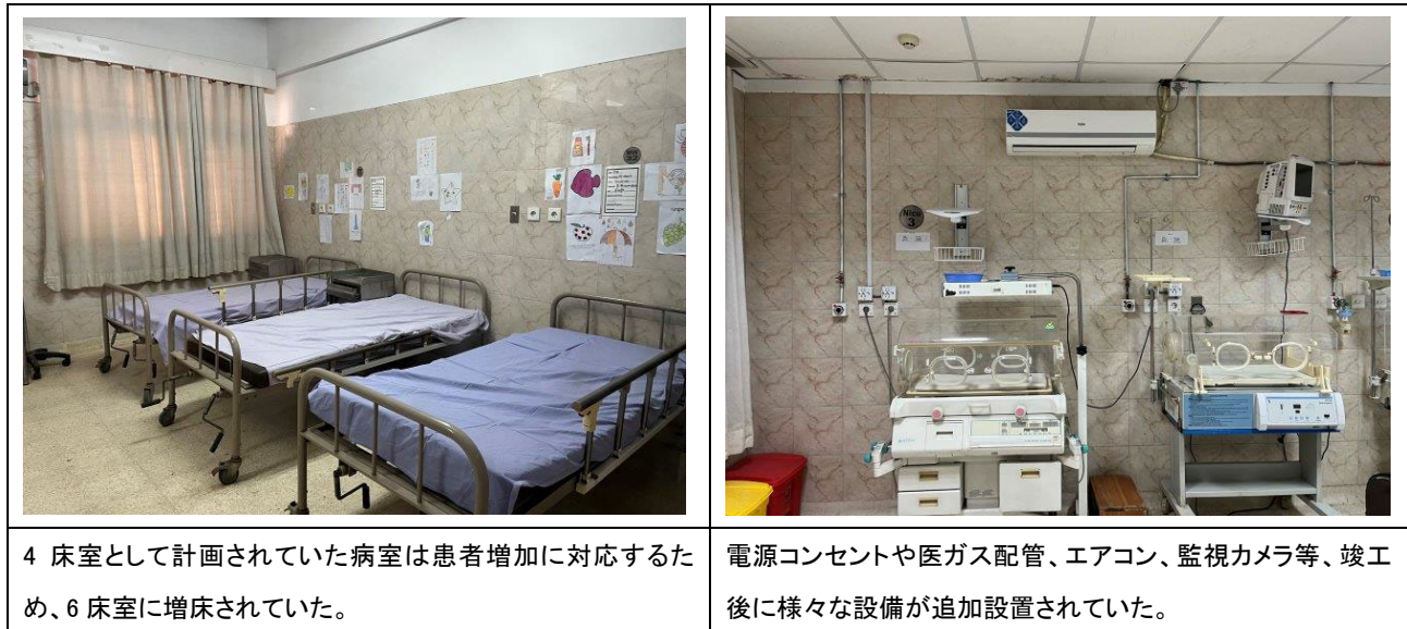
図 5-28 カラチ小児病院における施設維持管理状況写真
