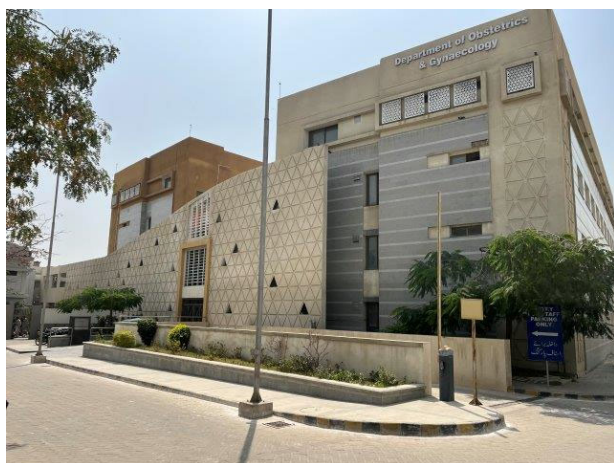
USAID 援助による産婦人科棟(フェーズ 2)外観
