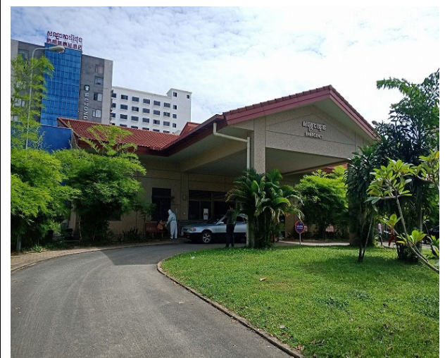
無償資金協力建物の入口で簡易検査を実施
