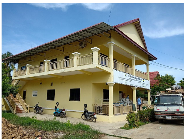
建物の1階が機材ワークショップ
