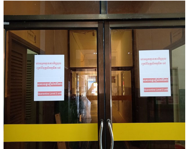
スペース不足により既存建物 (A 棟) の一部のみが隔離エリアとなっている。
