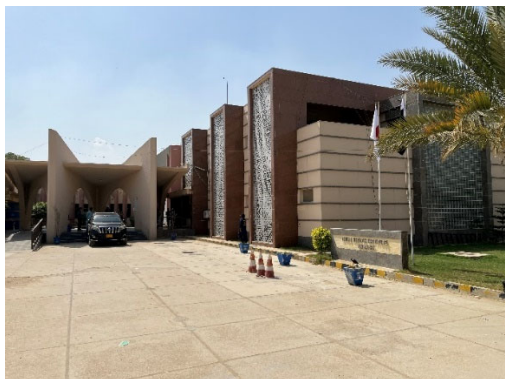
無償資金協力による施設外観
