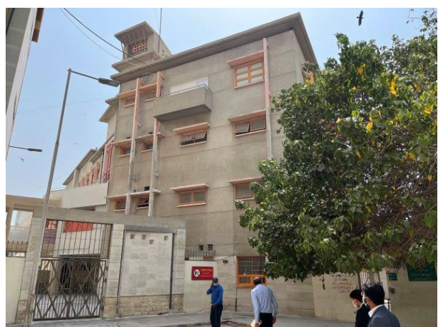
USAID 援助による産婦人科棟(フェーズ 1)外観
