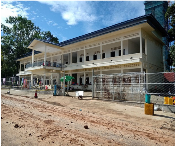
COVID-19 センター（B 棟）の周りは隔離用のフェンスが新設されていた。
