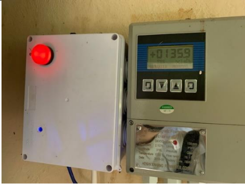
巻頭写真 3 電磁流量計の指示パネル 瞬時流量 135.9m 3 /時を示し、機能しているが、この計測値の運転管理への活用を図る必要がある。
