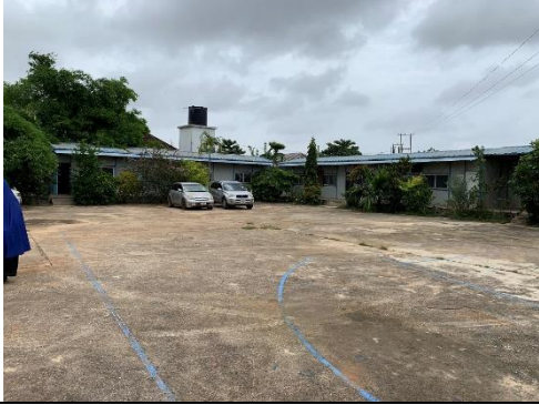
巻頭写真 9 ZAWA トレーニングセンター ZUWSP の工事業者が現場事務所として設置した建物を流用している。
