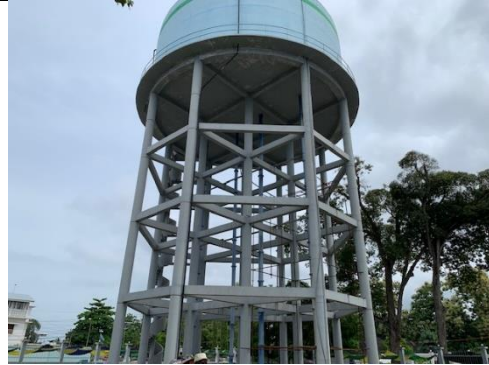
巻頭写真 6 ZUWSP で建設された高架式配水池 RC造、有効容量 1,000m 3 のムナラワンプオ配水池。稼働している。
