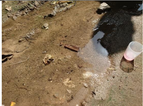
巻頭写真 16 検針業務同行時に確認された漏水 漏水（水溜まり）が水道水であることを確認するためバックテストで残留塩素を確認し、検出された。
