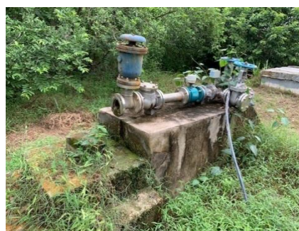
ポンプが撤去された井戸（更生井戸）
