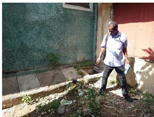
メーター設置状況
