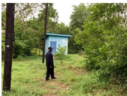
ポンプが撤去された井戸（更生井戸）
