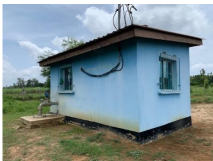
井戸外観（新設井戸）
