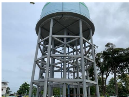
ムナラワンバオ配水池
