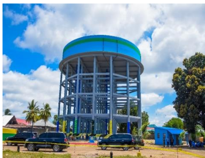
サティニーニ配水池
