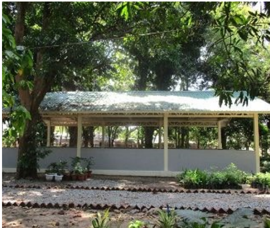
完成した作業小屋の外観
