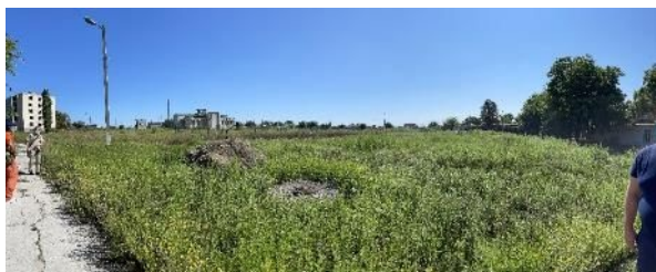
Foto 2-4 Noul șantier al centrului de formare Folosit ca loc de depozitare temporară pentru echipamente (orașul Răzeni)
