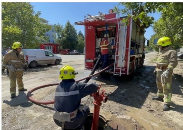
写真 2-12 消火栓からスタンドパイプを用いて給水している様子
