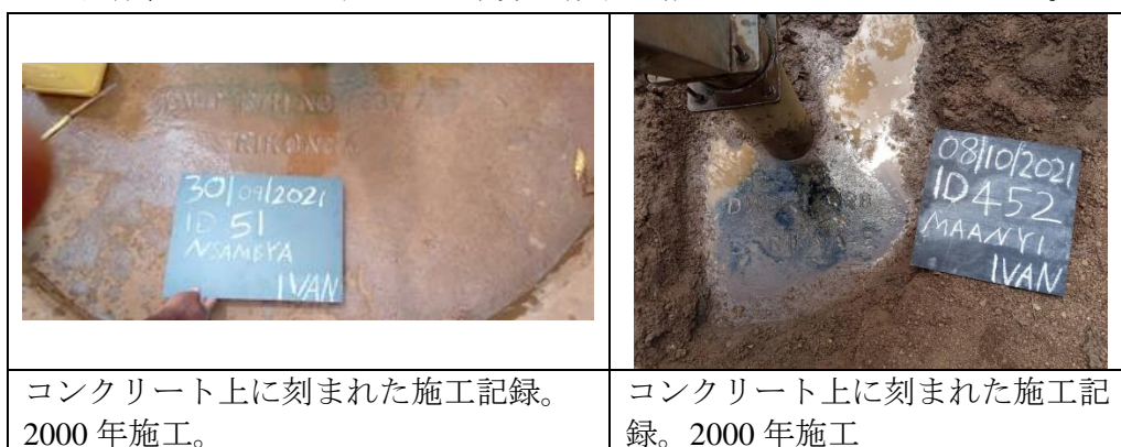
図 3-24 ハンドポンプのコンクリート現状例
