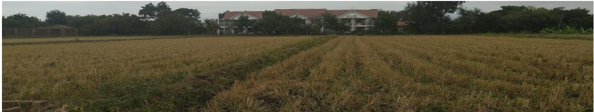
水田と新たに建設中の宿泊施設
