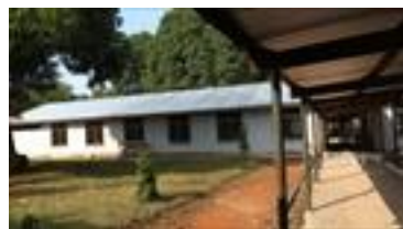
リノベーション中の宿泊施設
