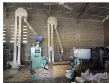
写真 3-17 地域内の精米施設
