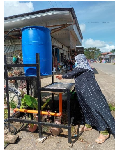
写真 5-2 設置した手洗い施設 出所 MARADECA
