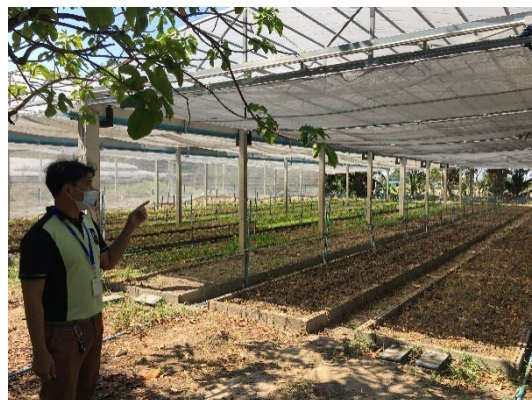
グリーンハウスと遮光カーテン。今回、遮光カーテンを自動開閉できるシステムを導入。それまでは労働者が棒を用いて開閉していた。
