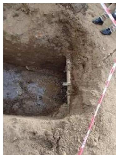
図 2-6-13 老朽化の進むアスベスト配水管
