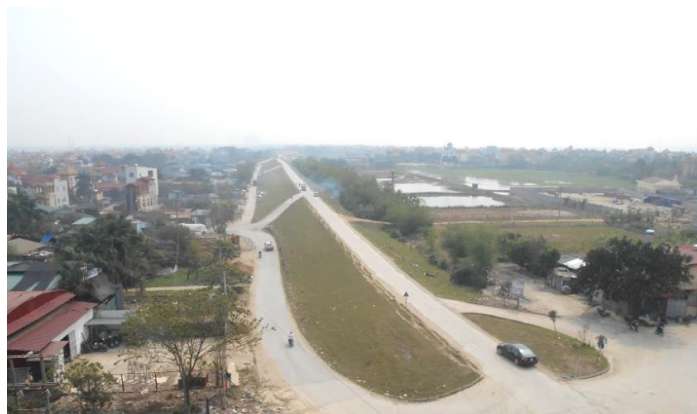
図 3.3-20 北部 Hong 川デルタ地域の堤防
