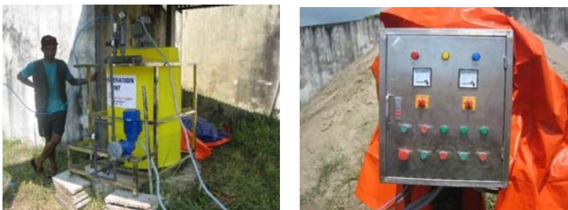
図 2.9 Pragatinagar WUSC における施設改修の状況 (左: 新設した塩素注入装置、右: 新設した現場操作盤)
