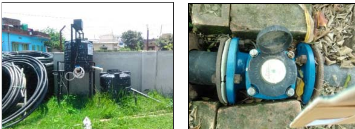
図 2.10 Pichhra 及び Mangadh WUSC における施設改修の状況
