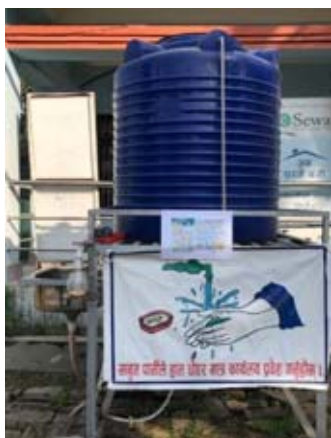
図 2.13 手洗い器の設置状況
