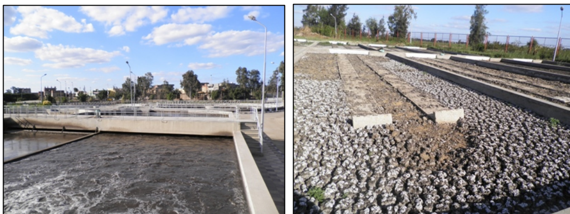
Kafr El Shake 県 El Reyad 地区の下水処理場
