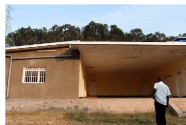
NAEB が建設した作物集荷センター (南部県 Kamonyi 郡)
