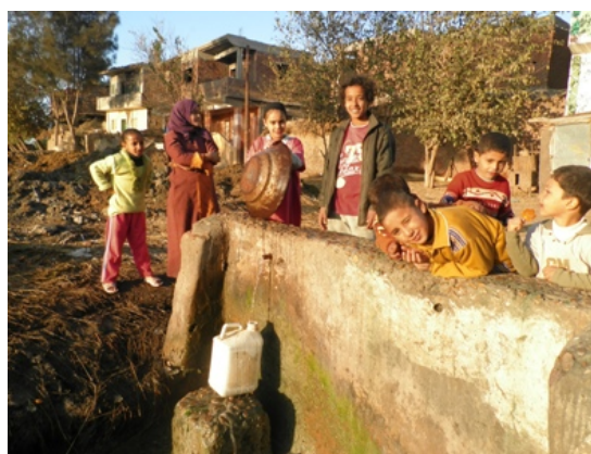
村の給水施設 (Kafr El Shake 県 Nahas 村)
