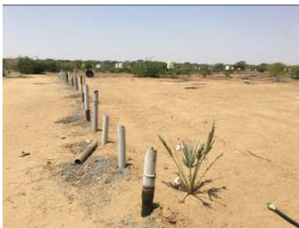
放棄された Napuu I Drip Irrigation Scheme
