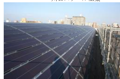
曲面屋根への設置事例
