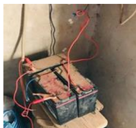
生徒宅の稼働していない バッテリー
