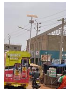
夜間点灯しないソーラー外灯
