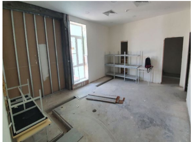
CT室（1階、写真左が搬入経路）
