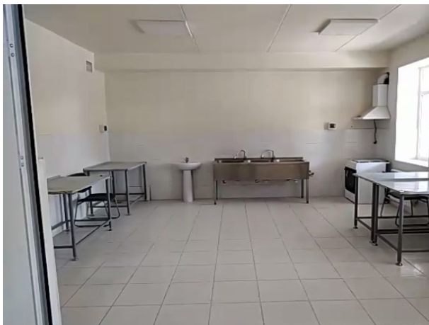
中央滅菌室（洗淨室）
