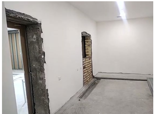
CT室 操作室
