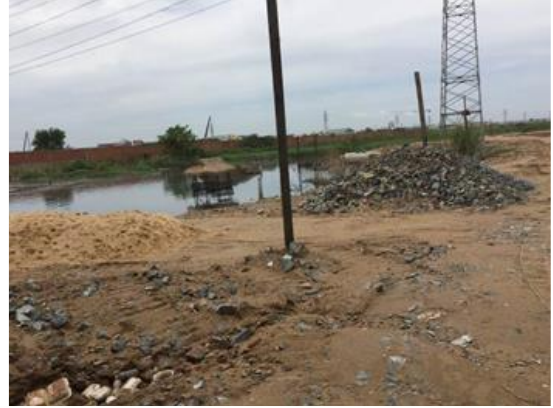
遮集施設建設予定地付近
