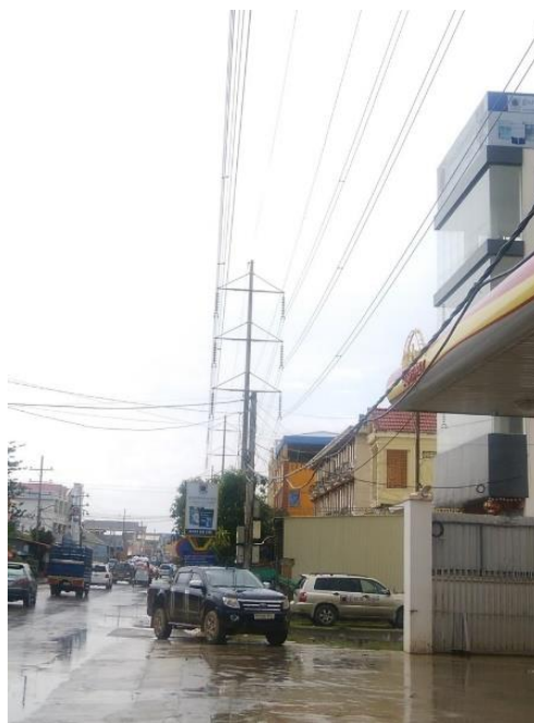
出所：調査団 写真 R 3.2.7 371 通り上の 22kV 送電線
