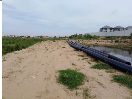
建設中の Hun Neang 道路
