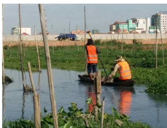
湖面での測量状況
