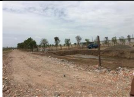
下水管理設予定地 (Trabek ポンプ場吐出口から南側を見る)
