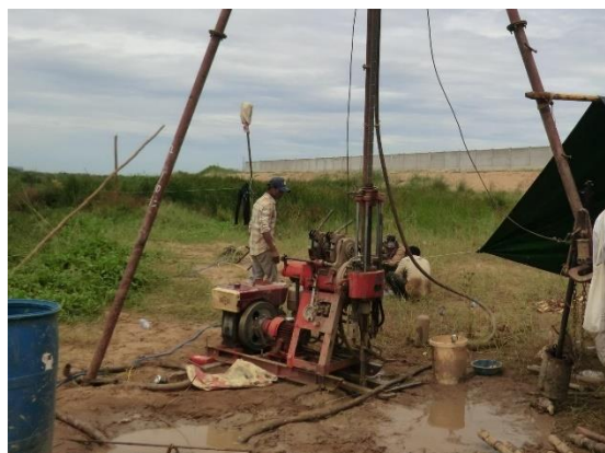
ボーリング No. 4 (BH-4) 地点
