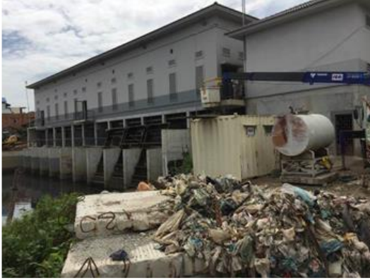
遮集施設の直上流に位置する Trabek ポンプ場
