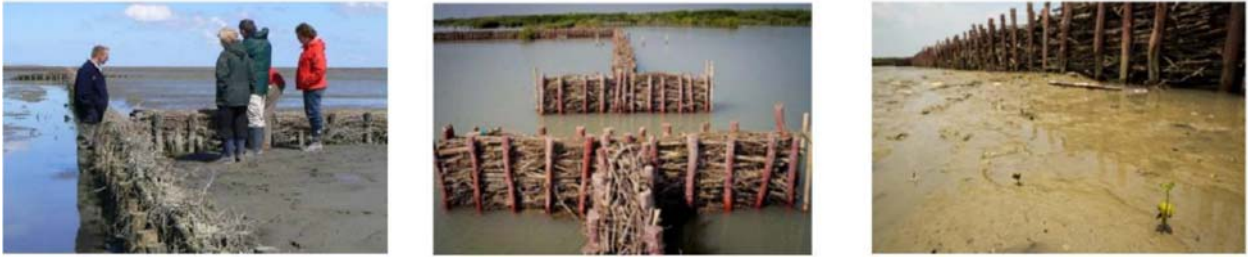
図 4-88 NGO によるマングローブ植栽と木製構造物を組み合わせた海岸保全工
