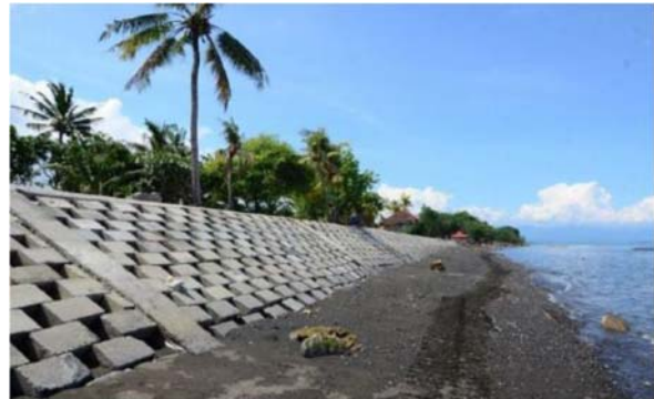
図 4-81 132 コンクリートブロック積護岸工 Desa Tukad Mungga, Bali North
