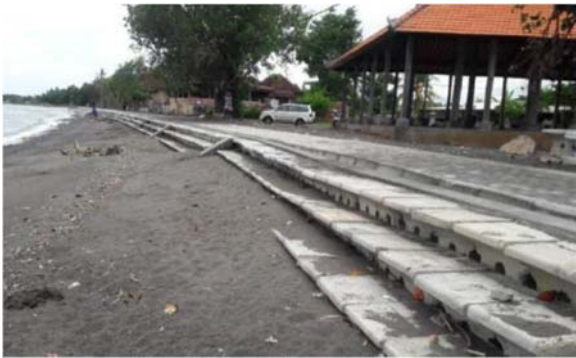
図 4-80 131 コンクリート階段護岸工 Desa TukadMungga, Bali North
