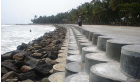
図 4-84 コンクリート海岸堤 Pantai Wameo, Kabupaten Bau-Bau, PUPR
