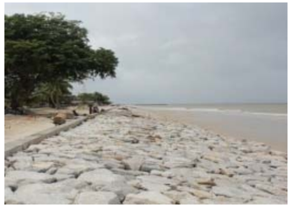
図 4-83 石積緩傾斜護岸工 Pengaman Pantai Pulau Rupert Kab.Bengalis BWS SUMATERA III RIAU, 2011
