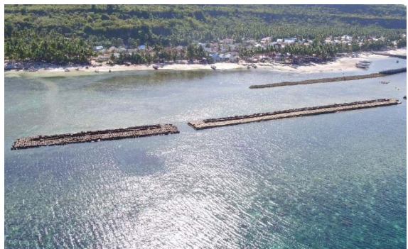
図 4-87 Offshore Breakwater 離岸堤
