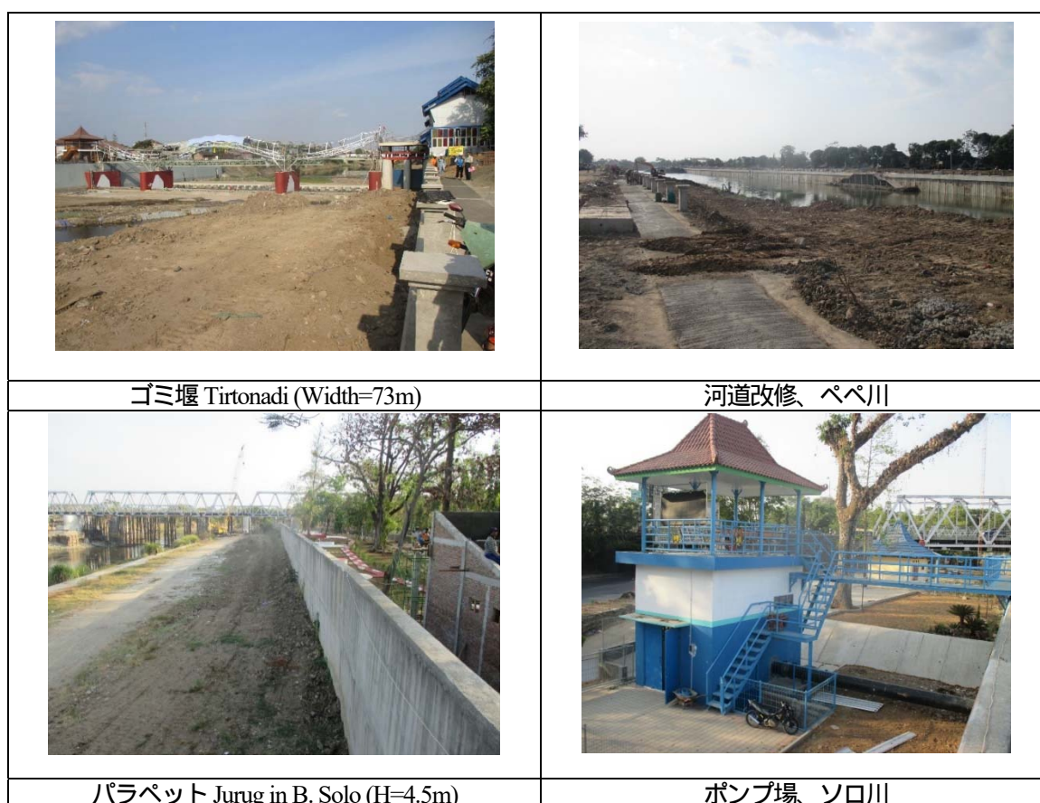
図 4-61 スラカルタにおける洪水対策工事状況の写真
