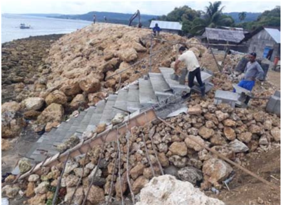
図 4-82 133 玉石積海岸堤護岸工 Morotai Is., North Maluku
