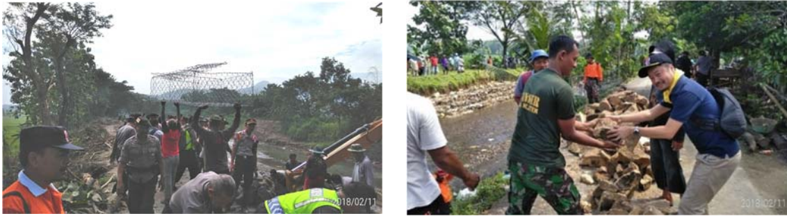
図 3-9 住民による河川堤防の修復活動（中部ジャワ州クラテン地区）
