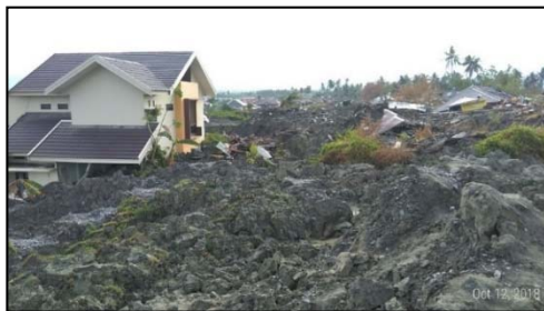
図 2-16 ペトボ地区の液状化地すべり
