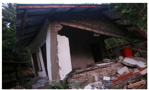
図 2-15 稚拙な建設のために崩壊した家屋(2)
