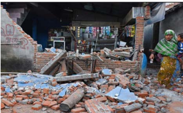
図 2-14 稚拙な建設のために崩壊した家屋(1)
