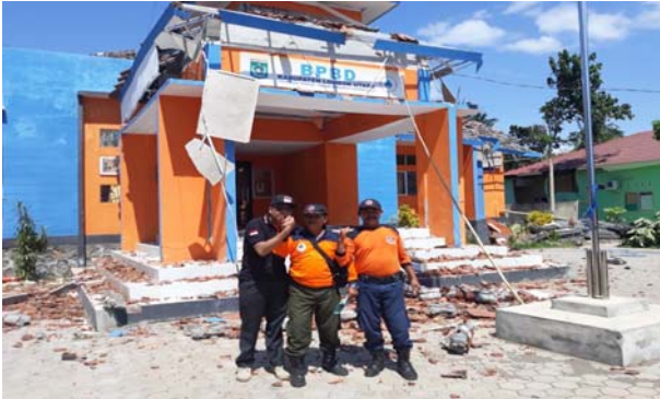
図 2-12 北ロンボク県で半壊した地方防災局事務所
