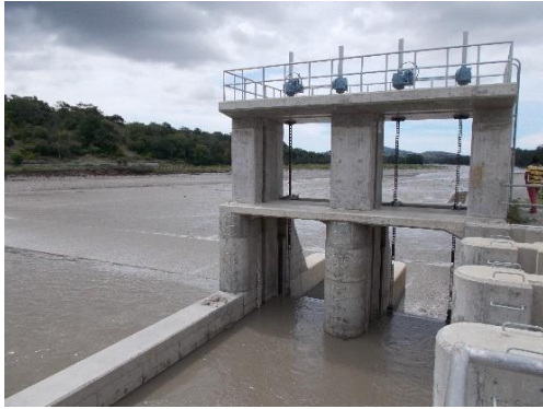
ブルト灌漑施設のメイン開閉門
