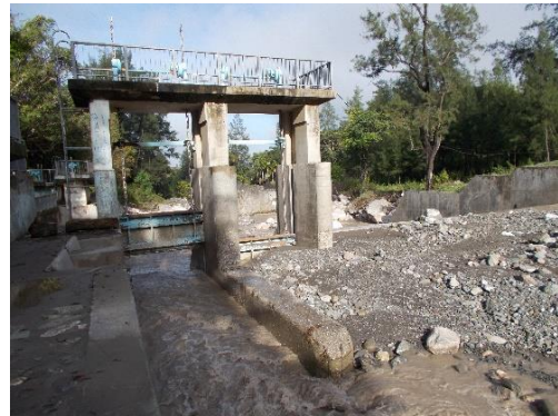
マリアナ I 灌漑施設 (右側のゲートは雨期の豪雨 で土砂がたまり、開閉門を閉じている)
