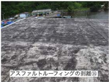
図 2-11 マリゴット漁港 市場・管理棟の損傷状況写真
