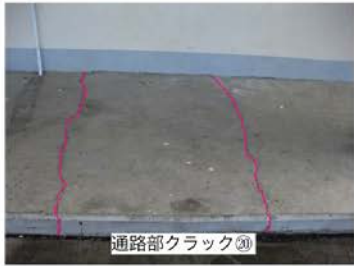
図 2-11 マリゴット漁港 市場・管理棟の損傷状況写真
