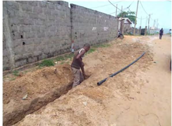
Construction des installations d'approvisionnement en eau par le gouvernement du Congo (2014.6)
