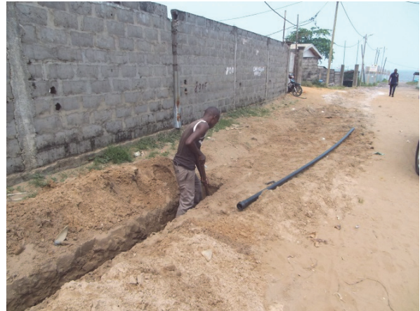
施設建設:先方負担工事(水道引込) 2014年6月
