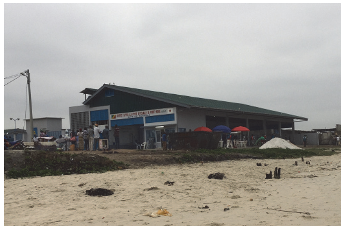
零細漁業支援施設 外観（浜側より）
