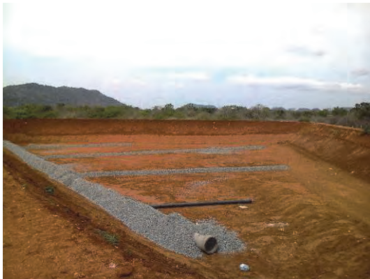
浸出水集排水管の全体
