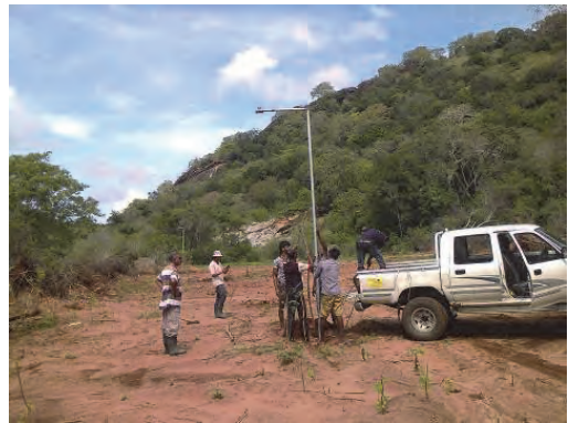
カタラガマPS最終処分場電気フェンス設置
