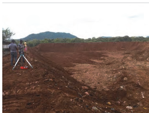
処分場工事 底部岩石除去後(5月)
