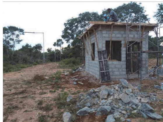
屋根型枠施工(2月24日)
