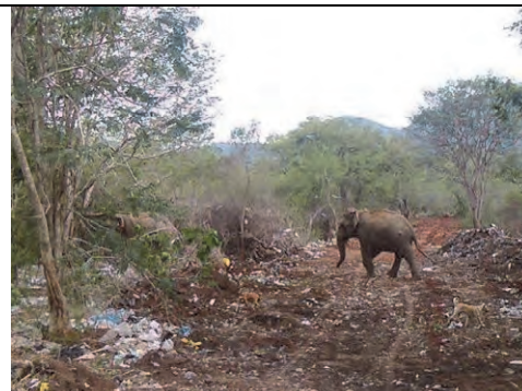
電気フェンス施工前 電気フェンス作業中に現れた象
