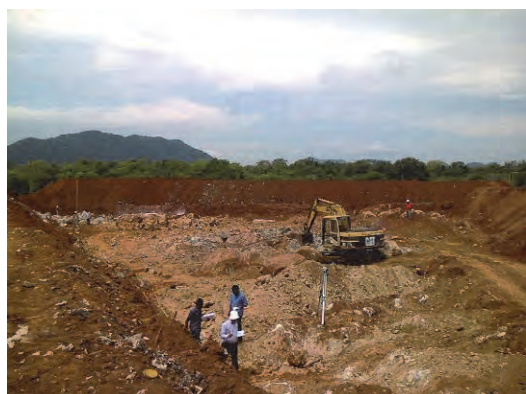
処分場工事 底部岩石除去前(5月)
