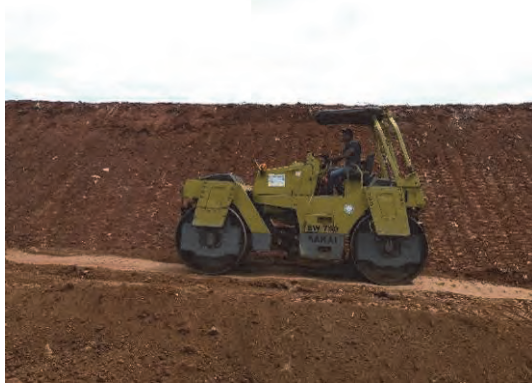
遮水層への転圧状況
