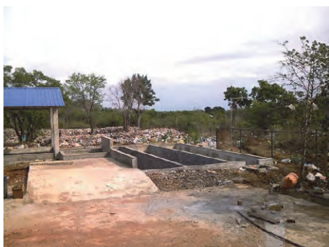
工事中のし尿処理施設
