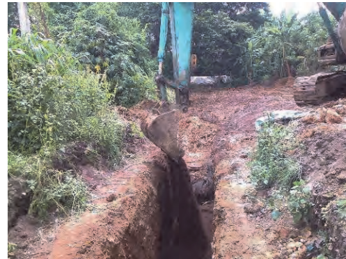
混合されたPRB材料の充填
