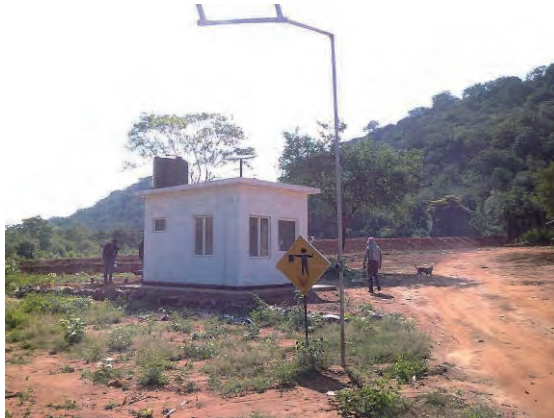
守衛所完成状況(4月25日撮影)
