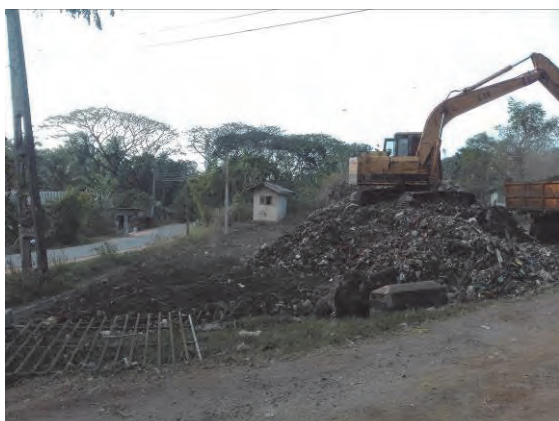
PRB施工箇所整地状況 (3月2日撮影)
