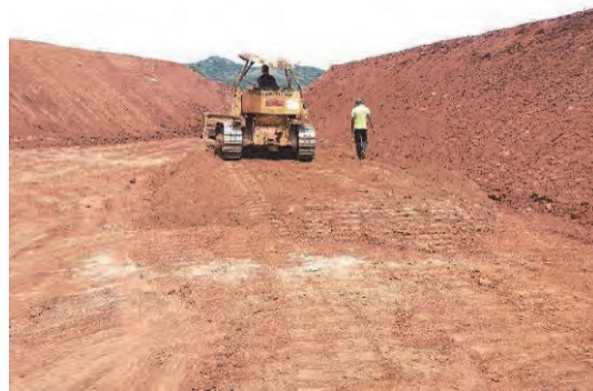
遮水層への転圧状況
