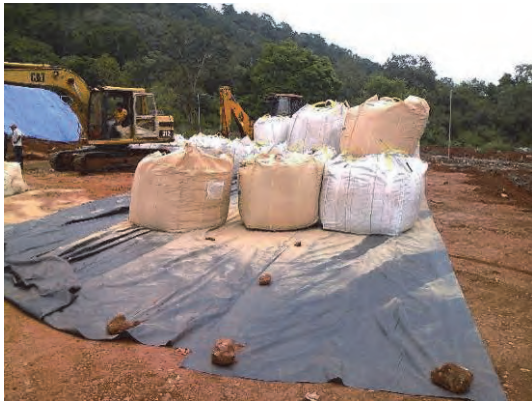
現場に搬入されたベントナイト（袋詰）
