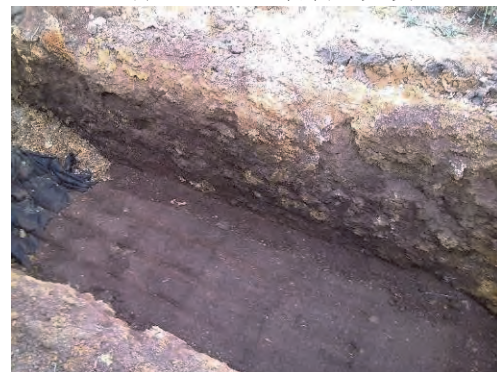
締固め後のPRB層
