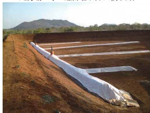
処分場工事の完成状況(9月)
