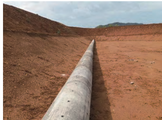
本管用の多孔コンクリート管
