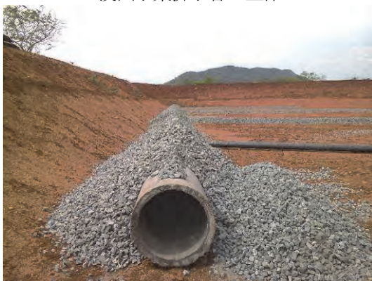
本管敷設状況
