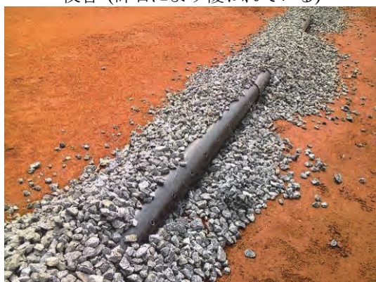
枝管用の多孔パイプと碎石施工状況
