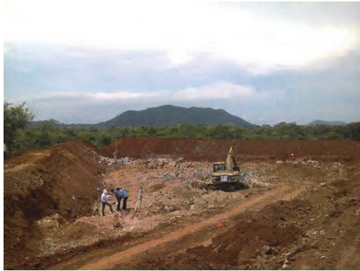
カタラガマPS処分場工事状況
