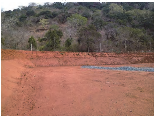
処分場底面への遮水層敷設状況
