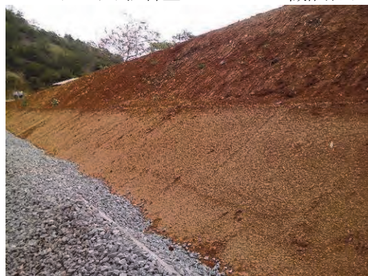
処分場内側法面への遮水層敷設状況
