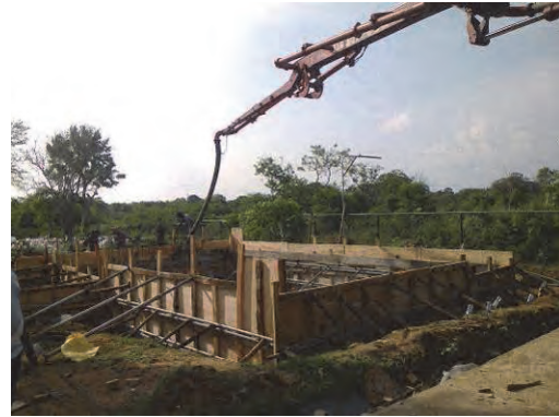
カタラガマPSし尿処理施設工事状況
