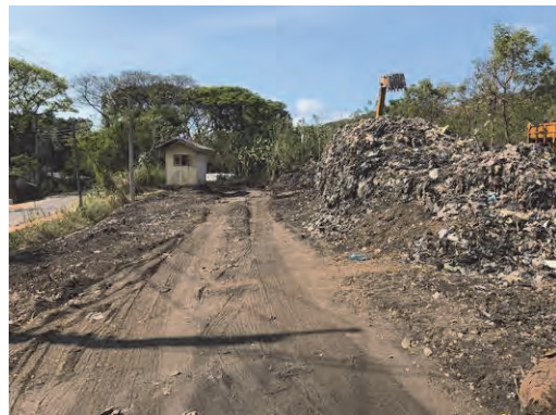
PRB敷設箇所 (クルネガラMC処分場)
