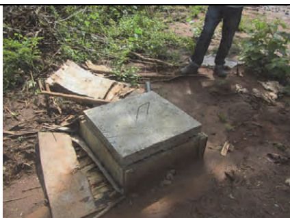
象による破壊のため保護した観測井
