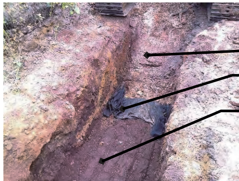
要求された締固め密度 1.0-1.1 \text{ kg/m}^3 までPRB層の締固め
