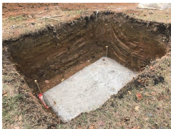
浸出水ピット建設
