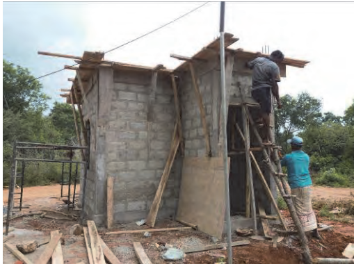
カタラガマPS処分場守衛所工事
