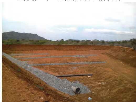
整地工事、浸出水集排水管の敷設完了(8月)
