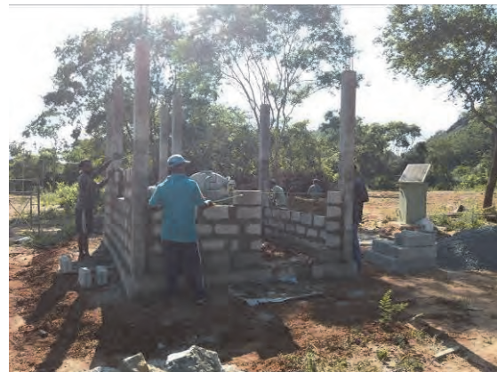
壁ブロック積工(2月20日)
