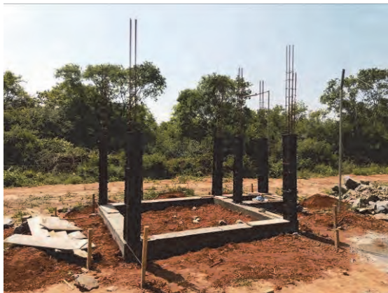
柱の鉄筋・型枠施工状況(2月18日)
