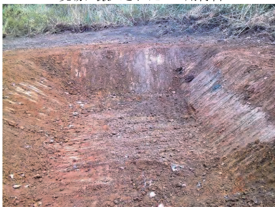
作業ヤード整備状況(2月27日撮影)
