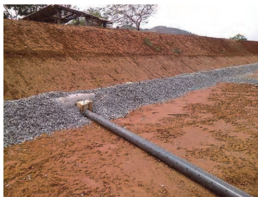
枝管の本管への接続部
