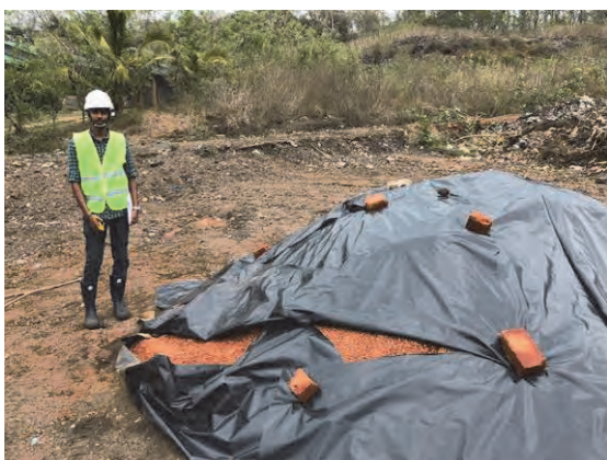
現場に搬入されたPRB用材料
