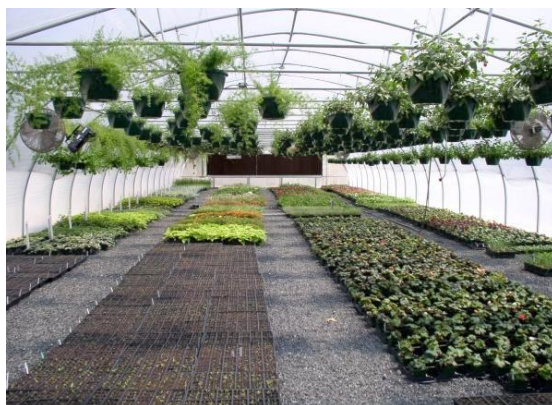
شکل ۱۴-۴ گلخانه گرم شده توسط LFG
