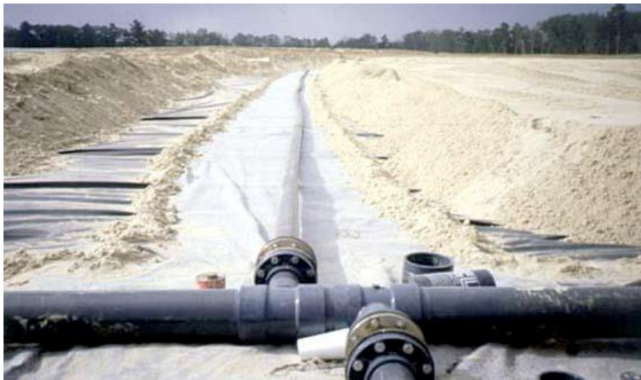
شکل ۱۲-۲ سیستم جمع آوری و انتقال شیرابه
