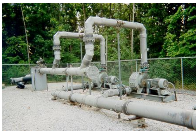
شکل ۱۴-۱ سیستم مرکب دریافت گاز در لندفیل
