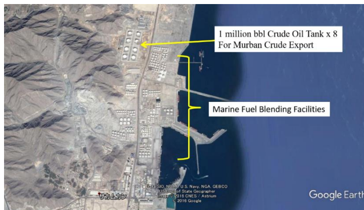
۹/۳ تجهیزات سوخت دریایی در بندر فجیره
