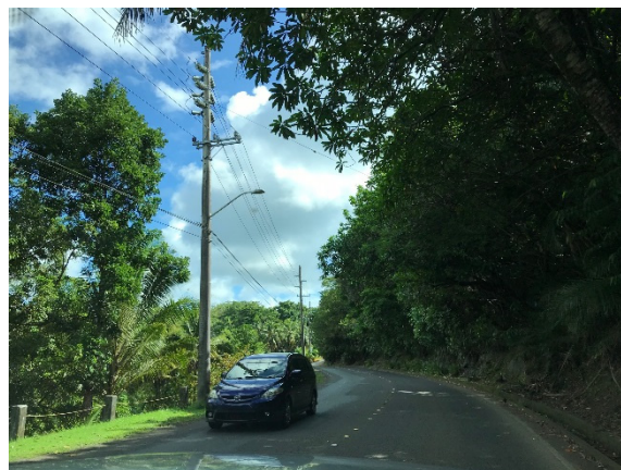
図 10-3-2-1.3 新たな電柱建設が困難な箇所の例 （コロール SS（新設）～コロール市街地入口間）
