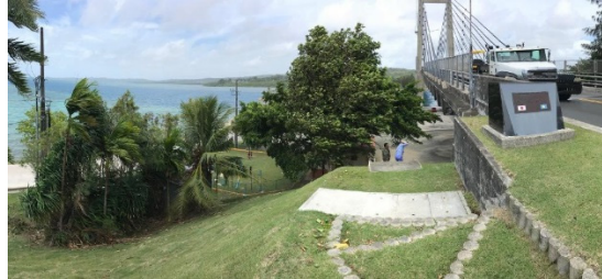
図 10-3-2-1.2 KB 橋引出部マンホール付近の状況
