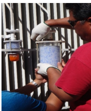
図 9-2-7.3 吸湿呼吸器取替の様子
