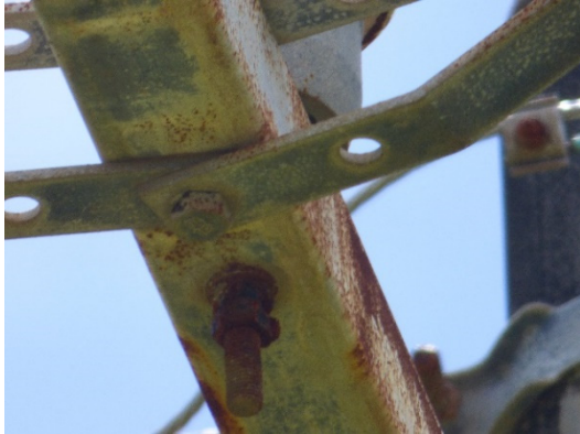
図 9-1-5-1.2 がいし固定ナットの緩み
