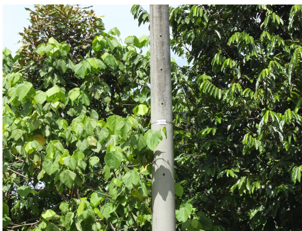
(d) ツタ巻き上がりの可能性がある電柱
