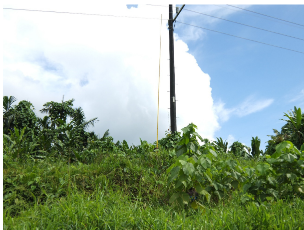
(c) 電線との離隔測定
