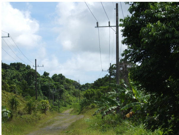
(a) ネッケン送電線の敷設状況
