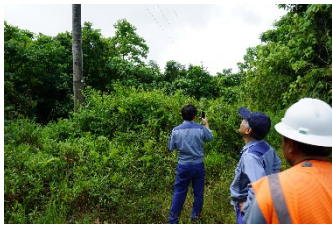
旧道に沿って設置された電柱
