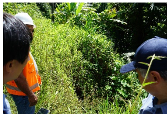
旧道の土砂崩れの現場
