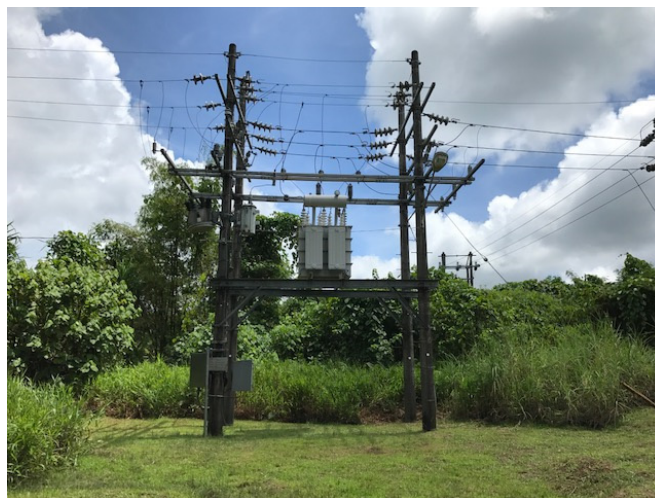
図 6-1-1-2.2 変電所設備の柱上施設例（アサヒ変電所）
