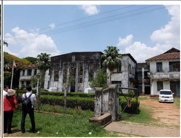
写真 2: 計画サイト A ゾーン 幹線道路から計画サイトへのアプローチ。写真中央の旧技術高校本館は先方負担にて撤去された。
