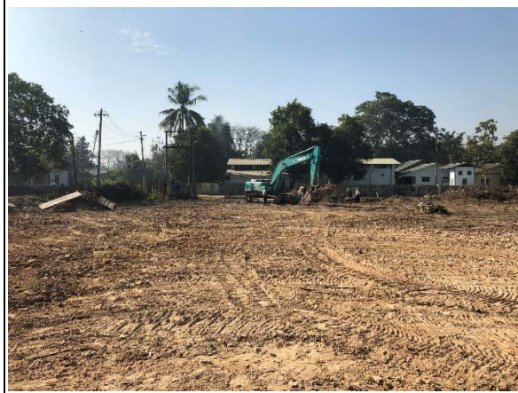
写真 3: 計画サイト A ゾーン 先方政府による既存建物撤去作業時。計画サイトは全体的に平坦、南西に向かって緩やかに傾斜している。
