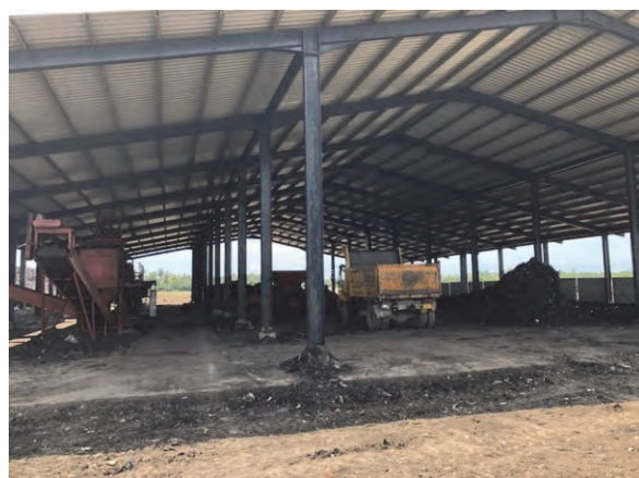
コロンボ市ムートラジャウエラのオープンダンプ処分場横のコンポストプラント (2018年5月7日)
