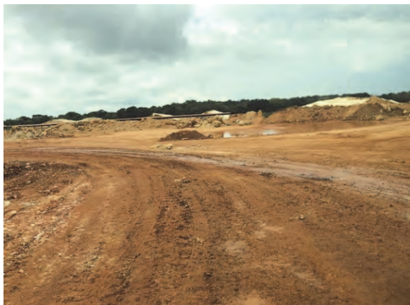
アルワカル・プッタラム衛生埋立処分場建設地 (2018年5月7日)
