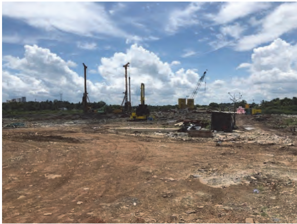
カラディヤナの焼却発電施設建設予定地（2018年5月12日）
