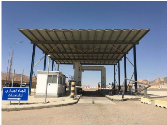
Yard-4 検査場に配備されている 固定式 X 線検査装置
