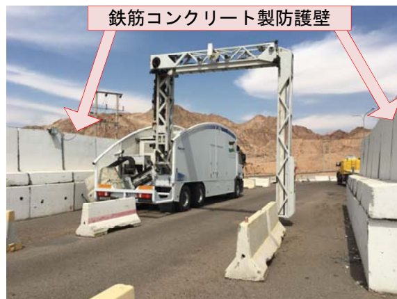
写真 3-1 鉄筋コンクリート製防護壁と X 線検査装置
