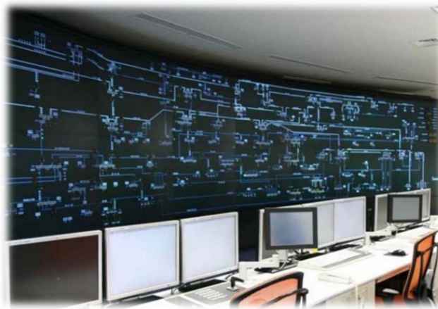
図 4-15 送電網モニタリング・制御のシミュレーション機能を備えた日本の訓練施設
