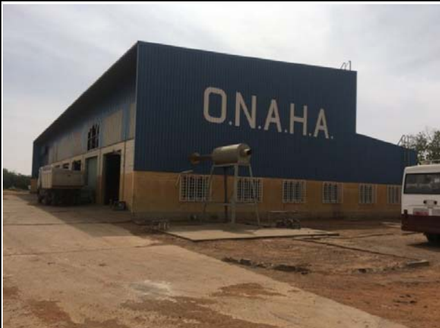
Photo 1 : Atelier d'entretien des engins de construction du siège de l'ONAHA
