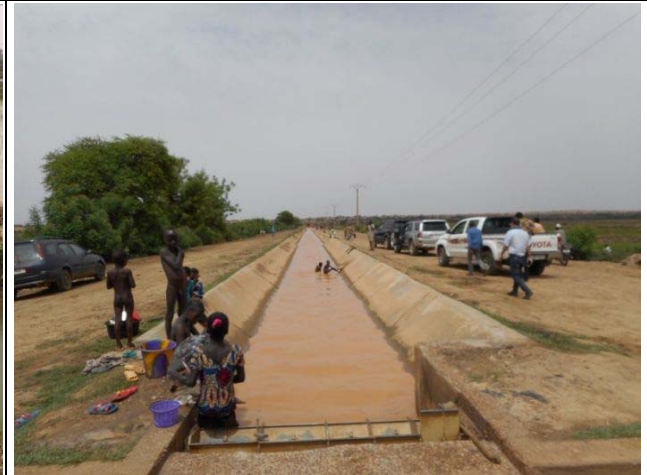
Photo 8 : Canal d'irrigation pour les AHA Tous les canaux primaires et secondaires des AHA sont revêtus.
