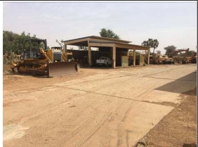
Photo 2 : Aire de stockage des engins de construction du siège de l'ONAHA
